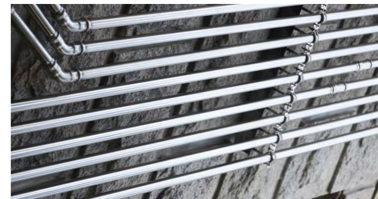
深圳市居民自来水改造工程
